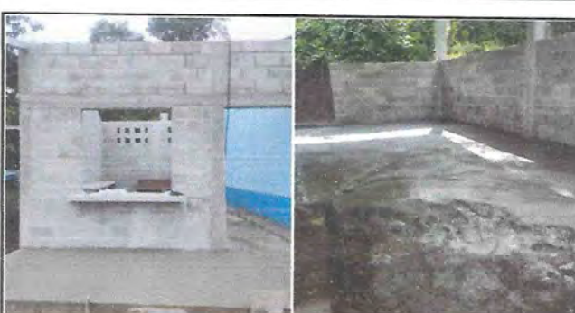
Foto 10: La torta de concreto estaba en malas condiciones y se está renovando y expandiendo.
