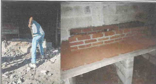
Foto 7: Se está reubicando la estufa rural y reconstruyendo totalmente para que esté al servicio de las cocineras del Centro Educativo.
