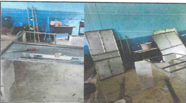
Foto 3: Las puertas de los baños y salones de clase están muy deterioradas, necesitan ser cambiadas.
