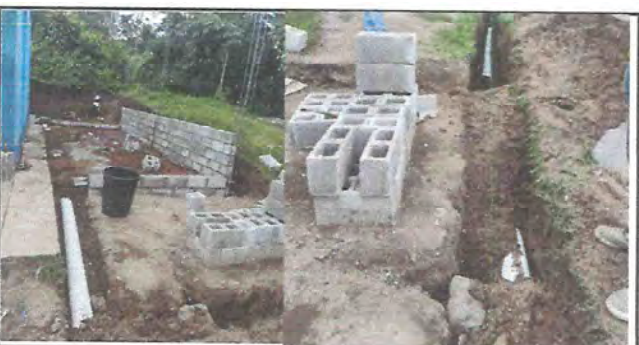
Foto 5: Se están mejorando drenajes e instalaciones pluviales para que se distribuya correctamente el agua.
